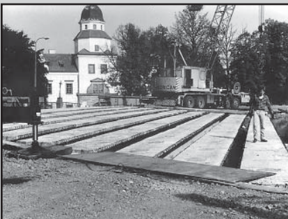
□ Foto 2 Pokládání železobetonové konstrukce v roce 1983.
